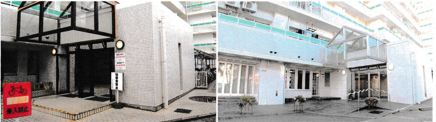
〈段差があった玄関をスロープに改修 (左)改修工事前、(右)現在〉
